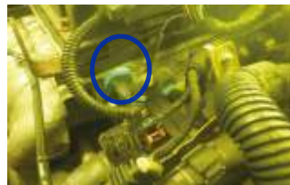
Détection de la fuite (en bleu) avec les lunettes UV
